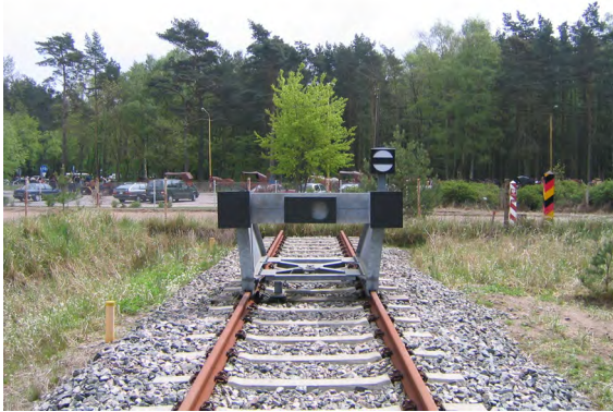
Abb.4: Ende der Schienenstrecke in Ahlbeck Grenze
